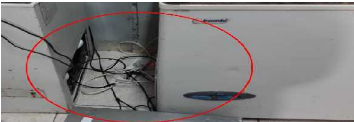
Ilustración 24 Cables enredados
