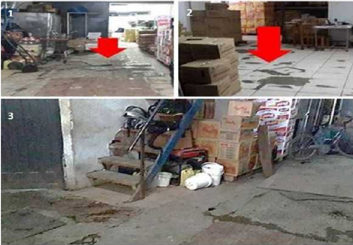
Ilustración 16 Falta de material impermeable y superficie irregular
