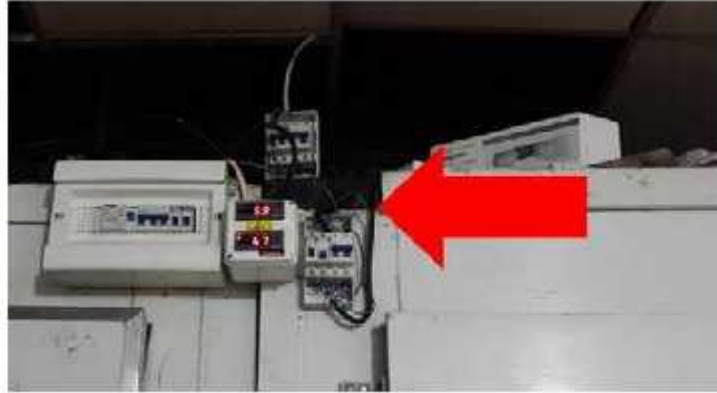
Ilustración 23 Instalaciones eléctricas inadecuadas: cables sin caños aislantes
