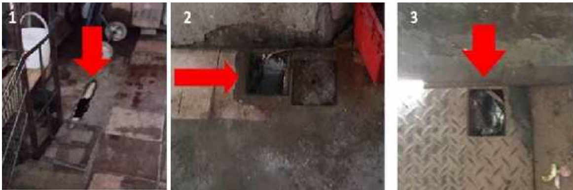
Ilustración 30 Cañería y cámaras por donde se eliminan los residuos
