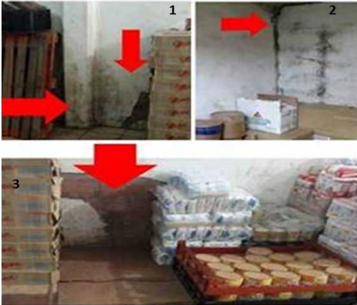
Ilustración 15 Falta de material impermeable. Mala higiene en paredes
