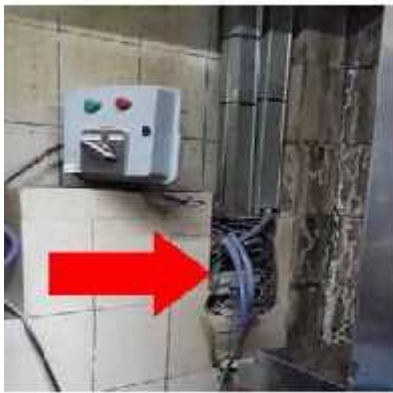
Ilustración 23 Instalaciones eléctricas inadecuadas: cables sin caños aislantes
