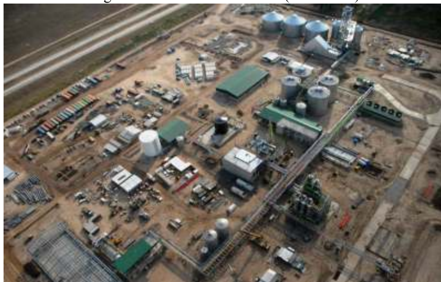
Figura 2.3 Planta de ACA BIO (vista aérea)
