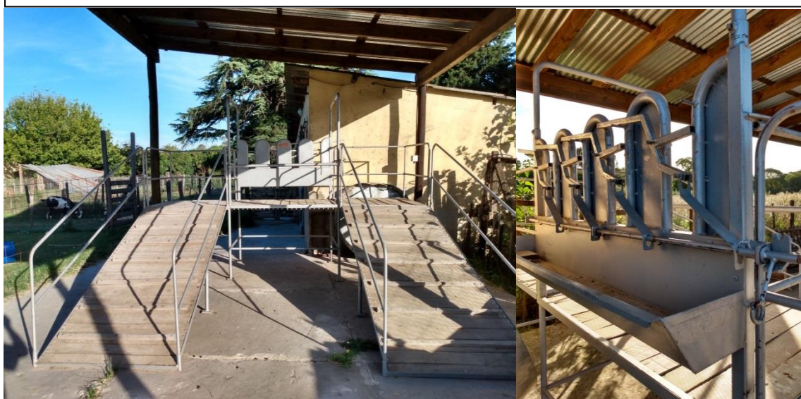
Figura 9: Tarima de ordeñe, vista de las rampas (foto izquierda) y de las trabas junto con el comedero (foto derecha),
