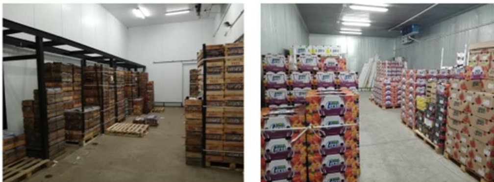
Figura 2. Cámaras de conservación. Izquierda; cámara refrigerada. Derecha; cámara refrigerada y ozonizada.
