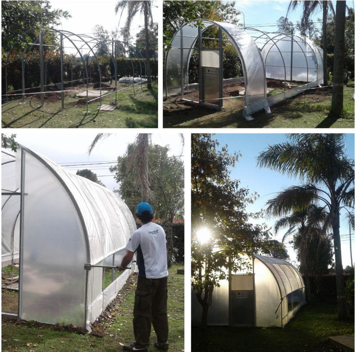
Figura 17: Construcción del invernáculo en la institución. Fuente propia.
