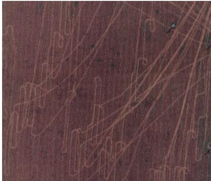
Figura 26. El lote presenta huellas en todo el lote por el uso indebido del carro tolva.
