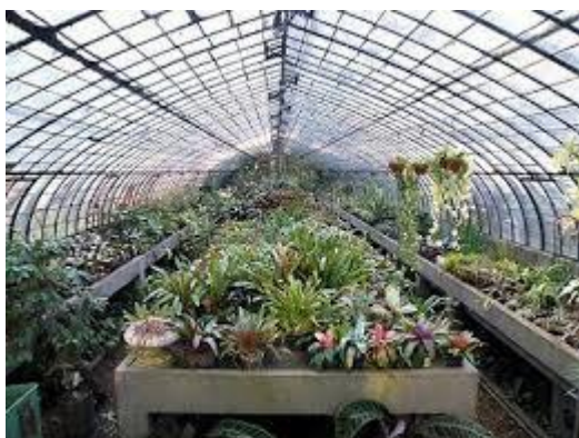
Figura 1 Invernadero construido en acero y vidrio "Jardín Botánico de Buenos Aires"
