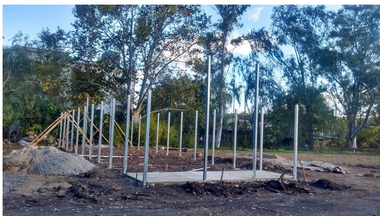
Figura 4 Construcción de invernáculo de estructura fija, EMAJEA (Escuela municipal de arboricultura, jardinería y ecología aplicada)"
