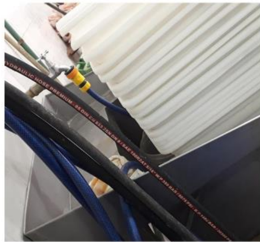
Bachas próximas al sector de trabajo que se encuentran obstruidas.
