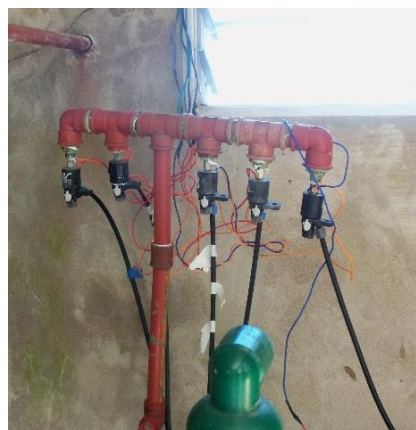
Foto 21. Líneas de fertirriego que van a los distintos lotes.
